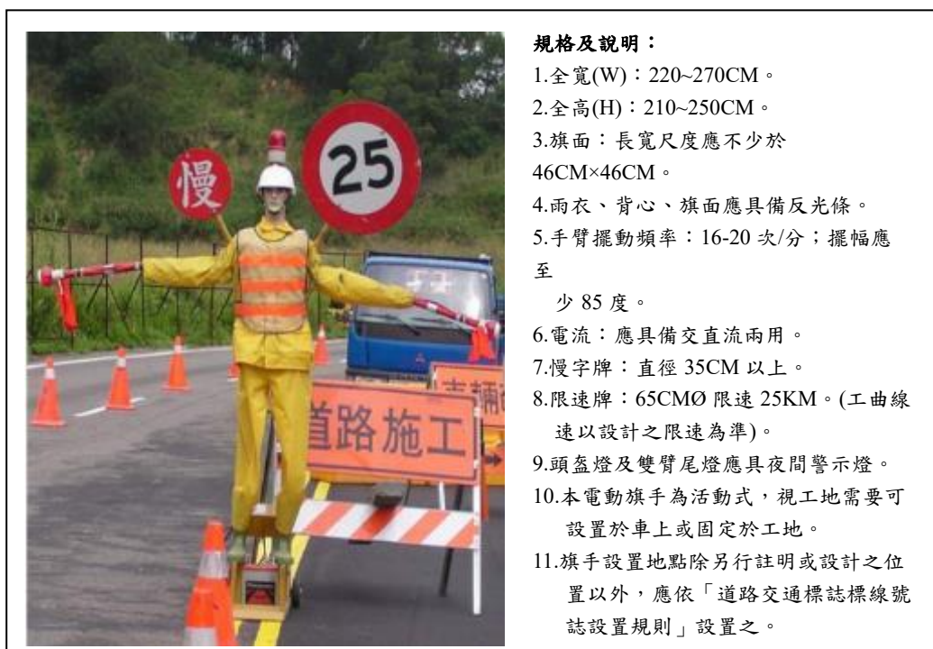
圖 11 使用道路作業設置交通引導人員、電動旗手圖例
