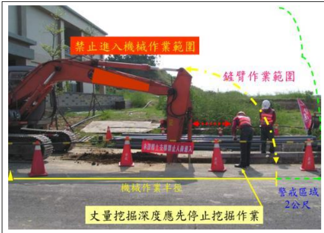
照片 11 挖掘深度測量，應在引導人員指示機械操作人員停止機械動作後，才能進入溝內
