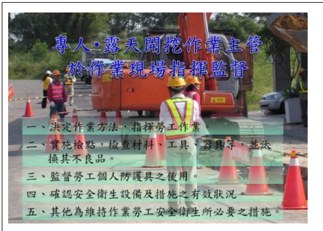
照片 12 管溝開挖作業期間，受指派之專人或露天開挖作業主管人員，應於「作業現場」辦理法定職務
