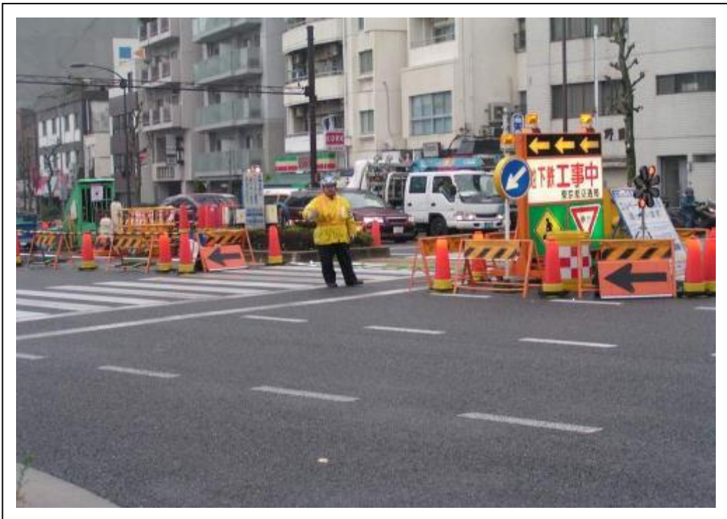
照片 06 使用道路作業設置交維設施及交通引導人員(日本)
