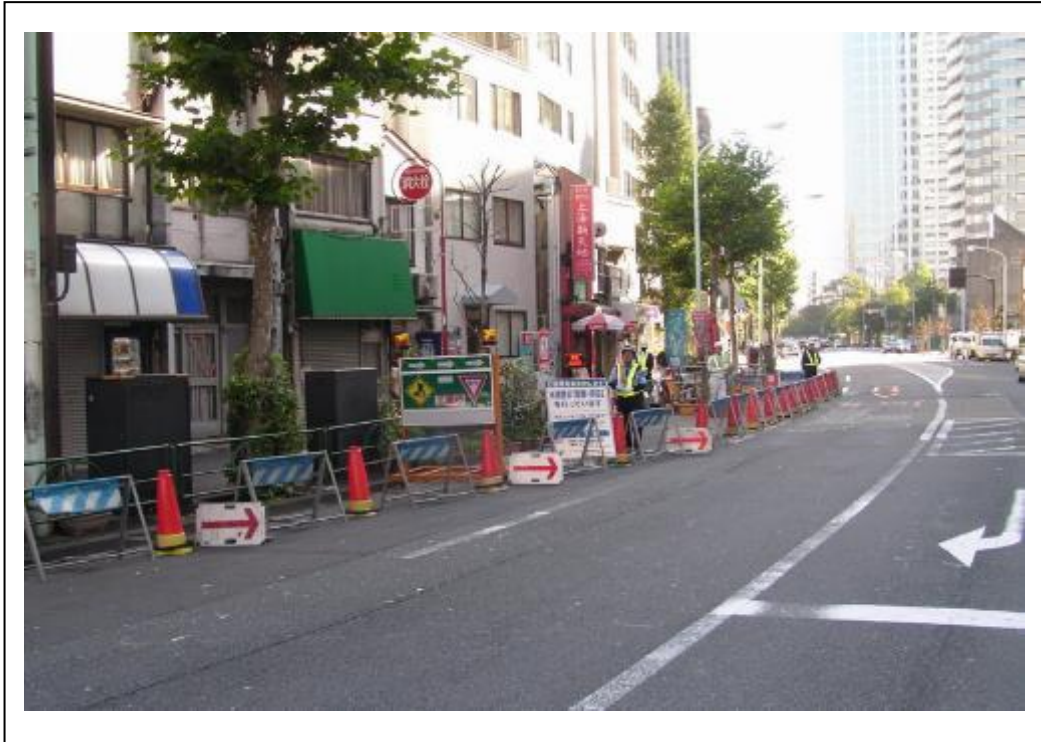
照片 07 使用道路作業設置交維設施及交通引導人員(日本)
